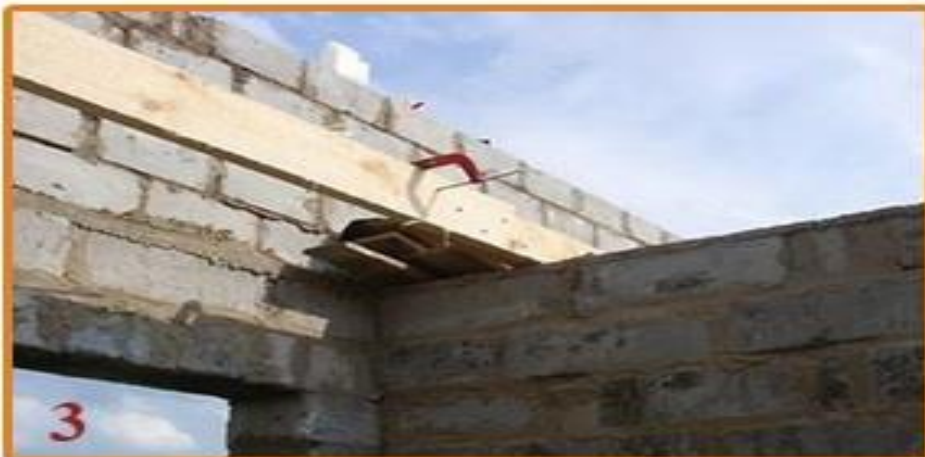
3. Стыкование балок болтами на внутренних стенах
