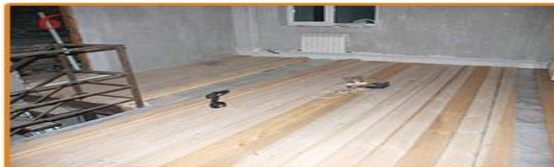
6. Крепление досок пола по балкам
