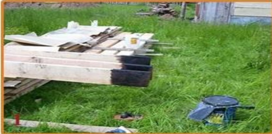
1. Покрытие концов балок антисептиками и битумной грунтовкой
