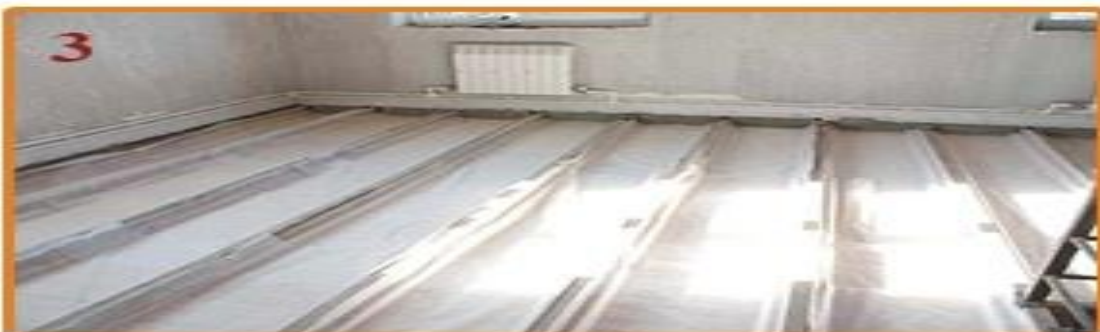
3. Укладка пароизоляционной пленки
