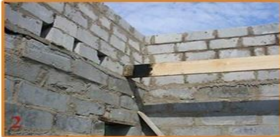
2. Оборачивание концов балок рубероидом и заведение в "гнезда" стен
