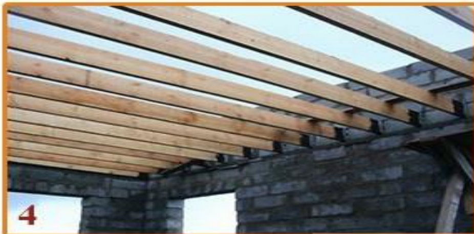
4. Закрепленные балки
