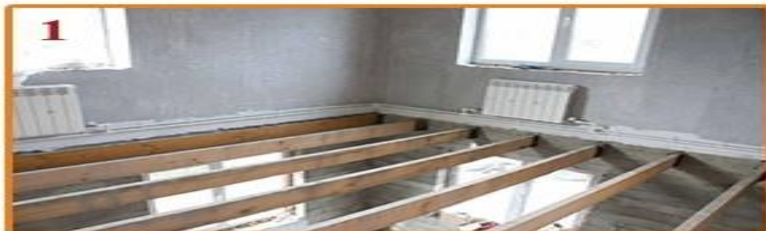
1. Размещение балок перекрытия в "гнездах" стен
