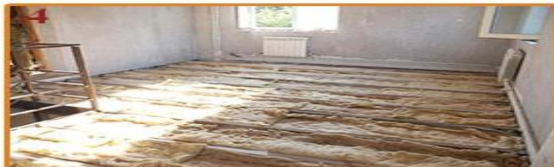
4. Укладка минеральной ваты (тепло- и звукоизоляции)
